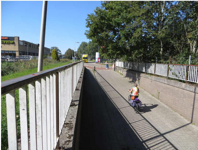
Fietstunnel ter hoogte van de afslag Nieuwerkerk aan den IJssel
