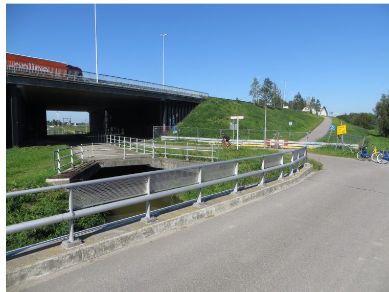
Viaduct en overkluizing Vijfde Tocht
