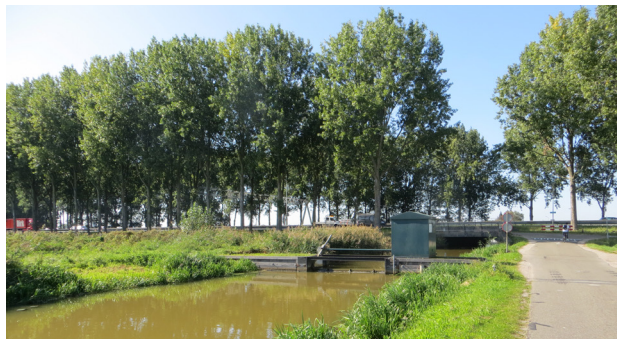
Bestaande duiker onder de A20 ter hoogte van de Tweede Tocht
