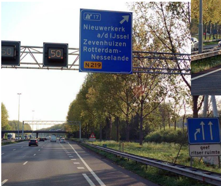
figuur 29: rijstrookversmalling Nieuwerkerk aan den IJssel richting Utrecht
