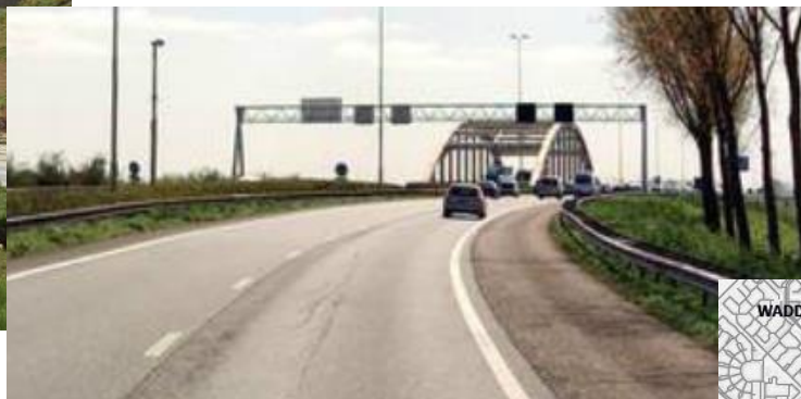
figuur 33: viaduct met boogconstructie
