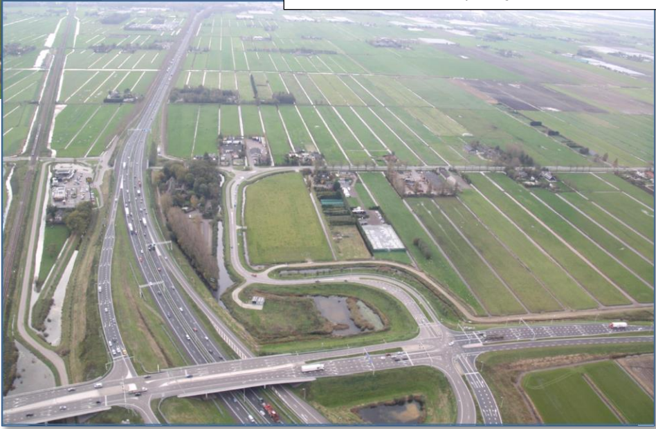
Figuur 20: De A20 in de Zuidplaspolder. Dit is wegvak 1, dat in de drie alternatieven wordt verbreed van 2x2 naar 2x3 rijstroken. Op de voorgrond de aansluiting Moordrecht. Links de spoorlijn Gouda - Rotterdam
