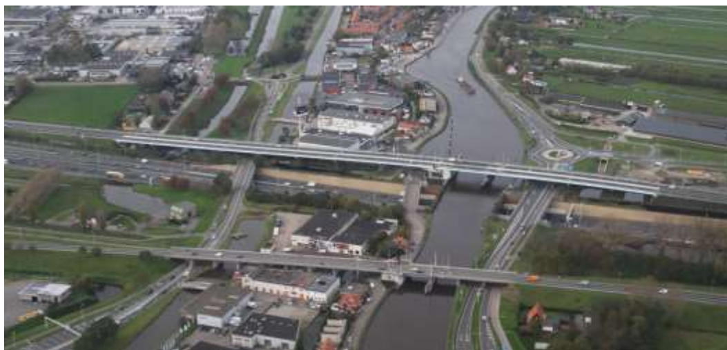
Figuur 4-7. Over de Gouwe liggen de Coenecoopbrug (voorgrond, tot begin jaren '80 de brug van de A12, het Gouwe-aqueduct (A12) en de Amaliabrug in de parallelstructuur. Iets zuidelijker ligt de spoorbrug over de Gouwe. De spoorbrug wordt op vaste tijden, gerelateerd aan de treindienstregeling, bediend.
