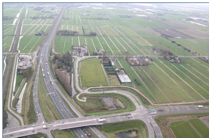
Figuur 2-3: Zicht op A20 richting Rotterdam vanaf aansluiting Moordrecht. Op de achtergrond wegvak 1, de huidige flessenhals met 2x2 (smalle) rijstroken
