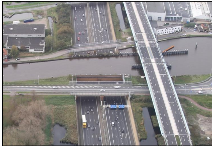
Figuur 2-2: Bovenaanzicht Gouwe-aquaduct en Amaliabrug van de parallelstructuur
