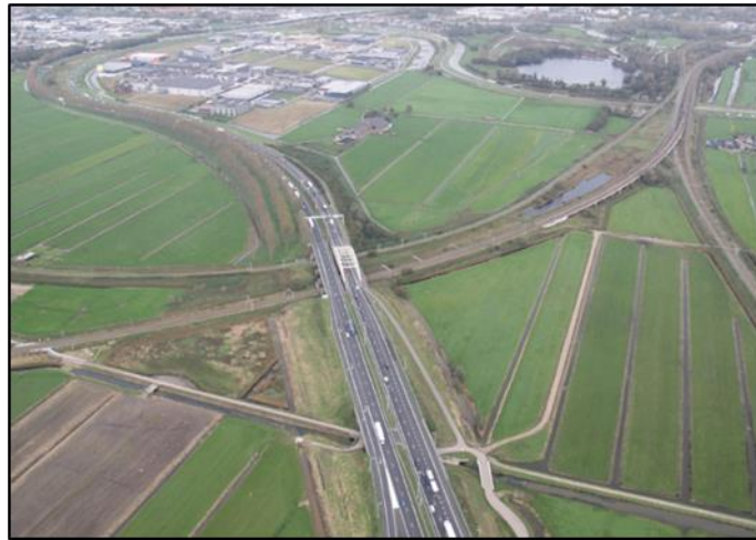
Figuur 2-4: Zicht op A20 richting Utrecht vanaf aansluiting Moordrecht. Zichtbaar zijn de twee kunstwerken over de spoorlijnen
